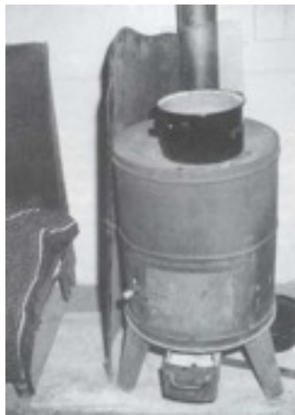
1965 Die Heizungsanlage im alten Schützenhaus
